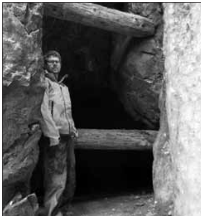
Mossgruvan. Mynningen till Vattenorten på cirka 20 meters avvägning (nuvarande vattennivå). Notera de gamla timmerstockarna som fortfarande finns kvar, trots att gruvan lades ned redan 1890. Foto: Jan Kruse.
