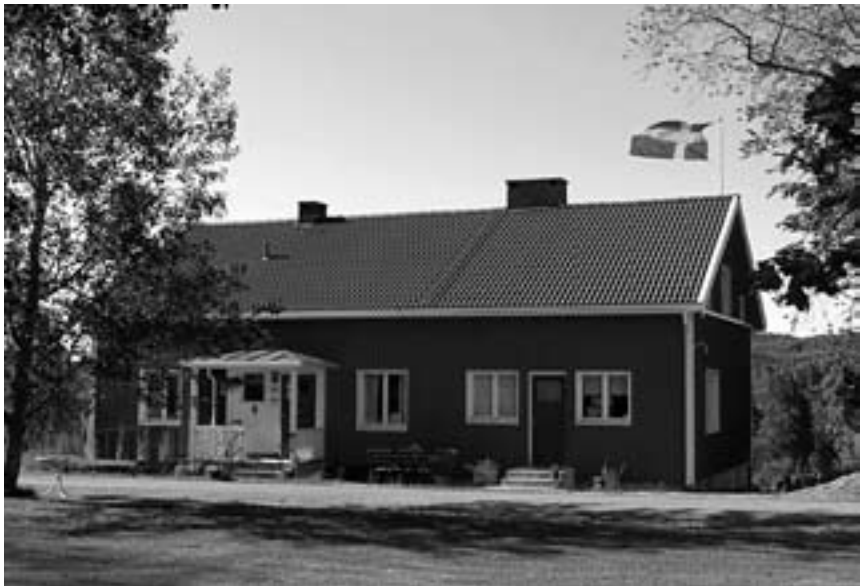
Arrendatorbostaden. En av Köla hembygdsförenings byggnader.
