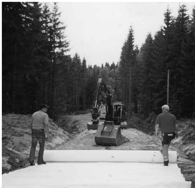
Älgå. Berndt Olsson och Bosse Solberg lägger ut fiberduk i området närmast hembygdsgården där det var lite blötare. Foto: Ingrid Aronsson.
